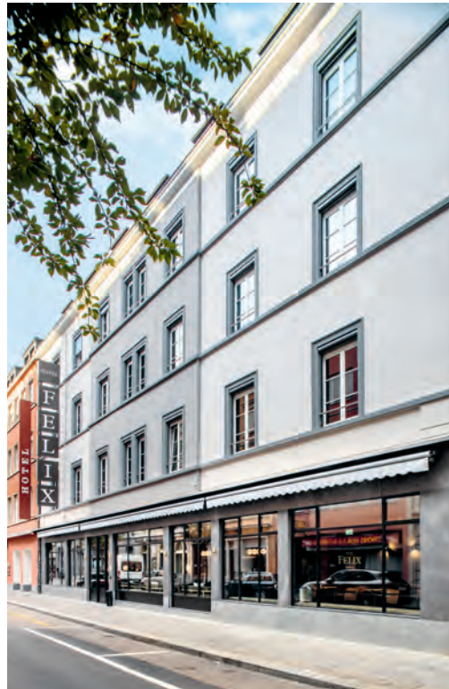
Die Fassade entspricht nun wieder dem Urzustand.
